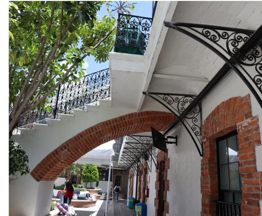
Imagen 64. Detalle de arco rebajado en escalinata, bóveda catalana y ménsulas de hierro, Edificio Central (A), Campus La Luz; agosto 25, 2023; EGA.
